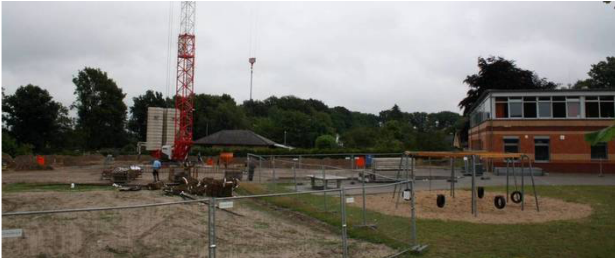
Auf dem Gelände hinter der Liesel-Anspacher-Schule haben die Bauarbeiten für ein Lernhaus begonnen. Foto: mix
